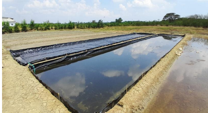
Gambar 3.27. Produksi Garam Menggunakan Geoisolator/Geomembrane
